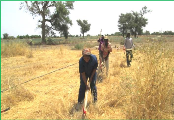
Creusage du canal de drainage
