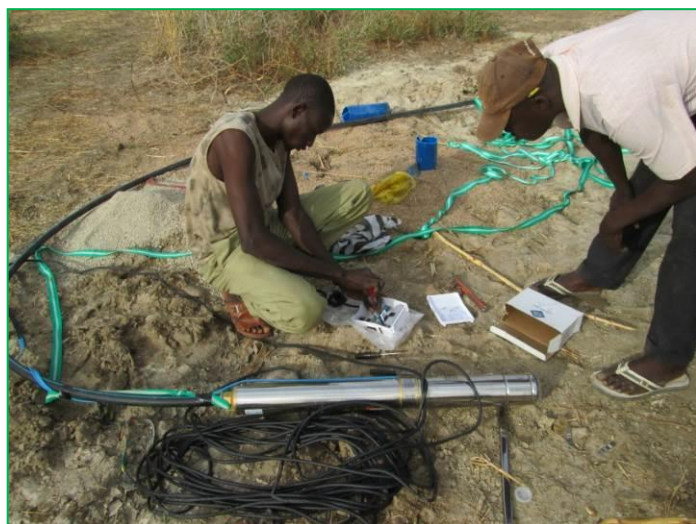
Installation de la pompe à immersion
