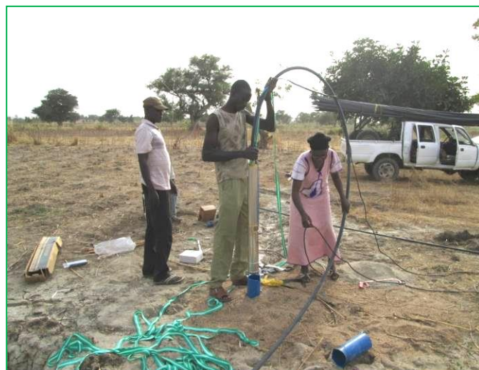
Installation de la pompe à immersion
