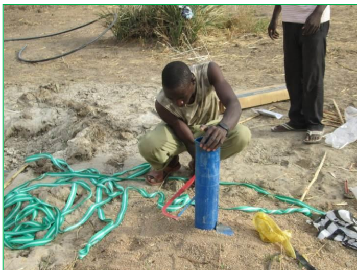
Forage en installation
