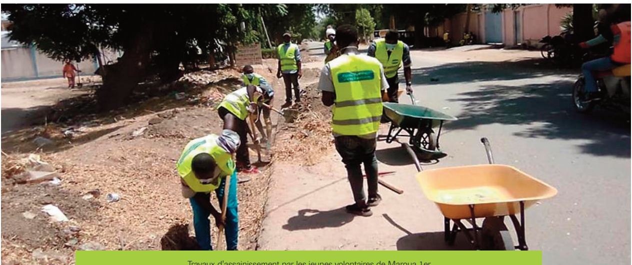
Travaux d'assainissement par les jeunes volontaires de Maroua 1er
