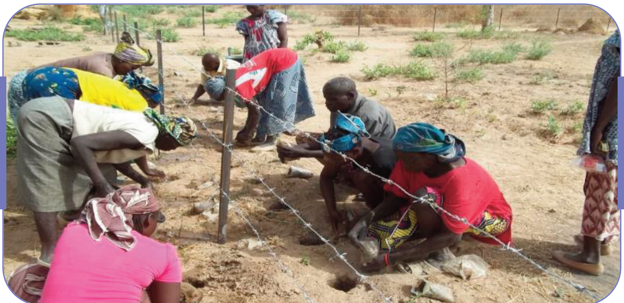
Travaux de sécurisation de la pépinière par les femmes de Doukoula dans la Région de l'Extrême-Nord
