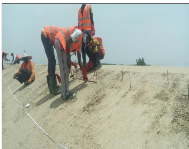
Photo 4 : Piquetage sur le talus par les manœuvres prête
