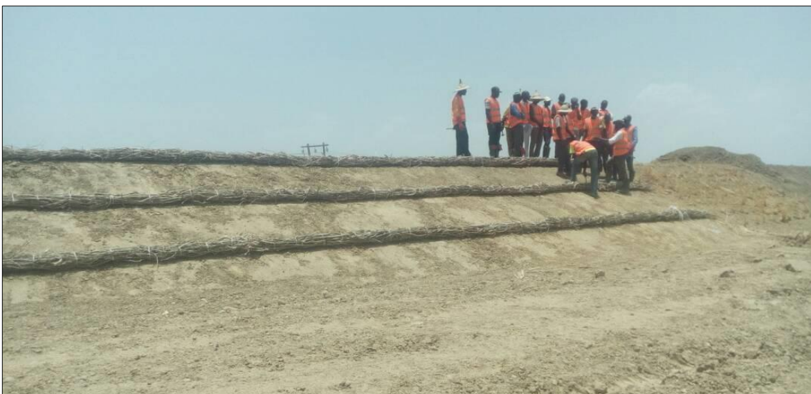
Photo 11 : Installation des fascines sur le talus par les jeunes volontaires
