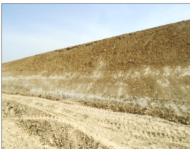
Photo 3 : Digue talutée, prête pour la végétalisation
