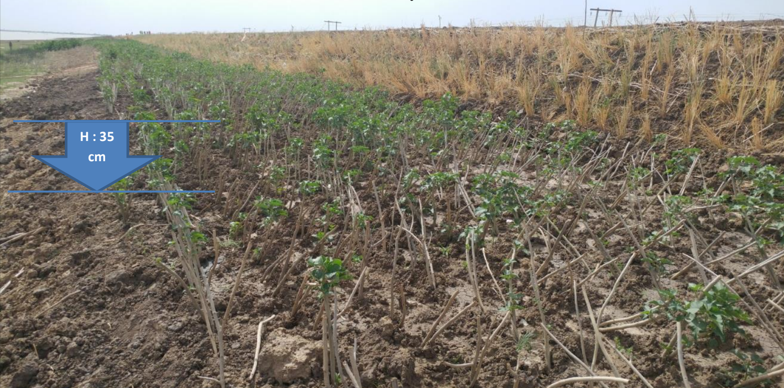
Photo 31. Protection des berges avec l'Ipomea : 10 jours après la mise en place des boutures Hauteur moyenne : 35 cm
