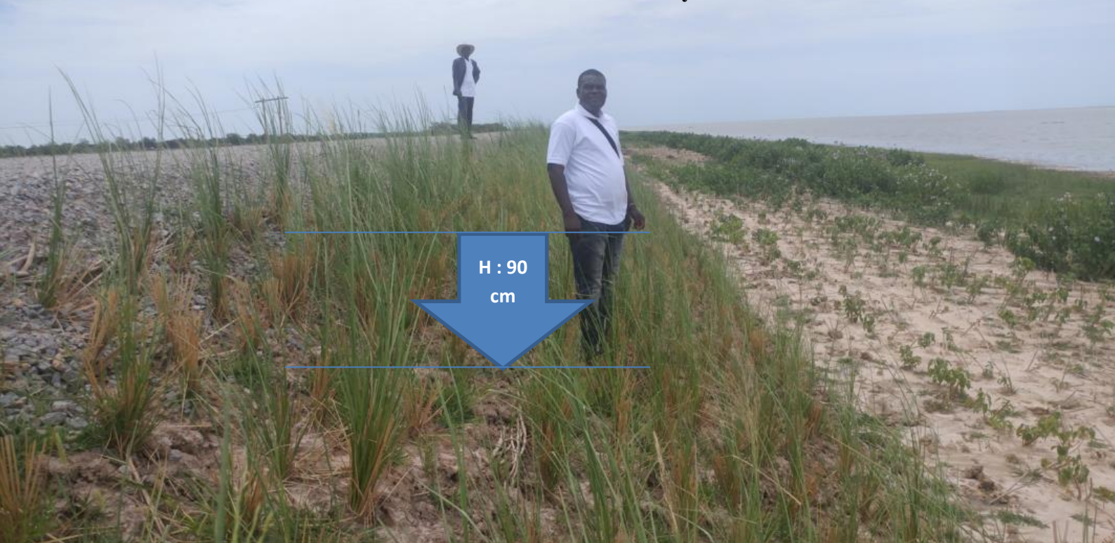
Photo 32. Protection des talus avec le Vétiver : 30 jours après la transplantation Hauteur moyenne : 90 cm
