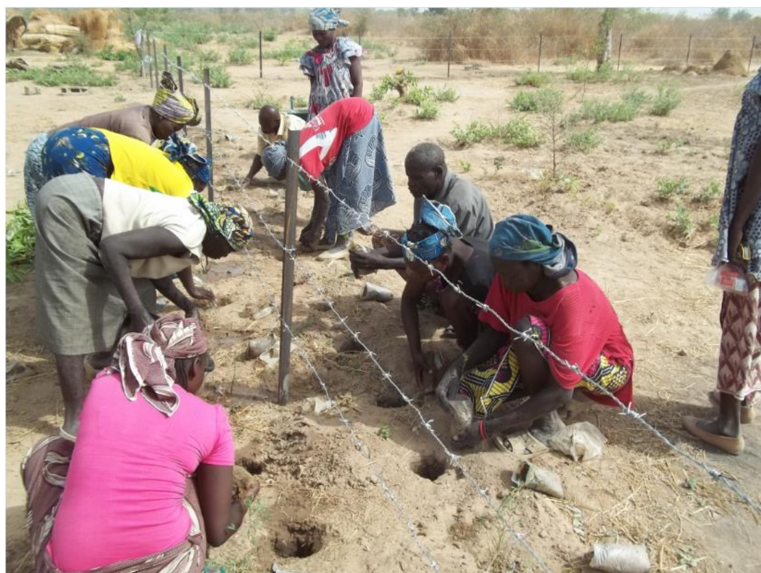
Installation de la clôture de la pépinière (fil barbelé et haie-vive)
