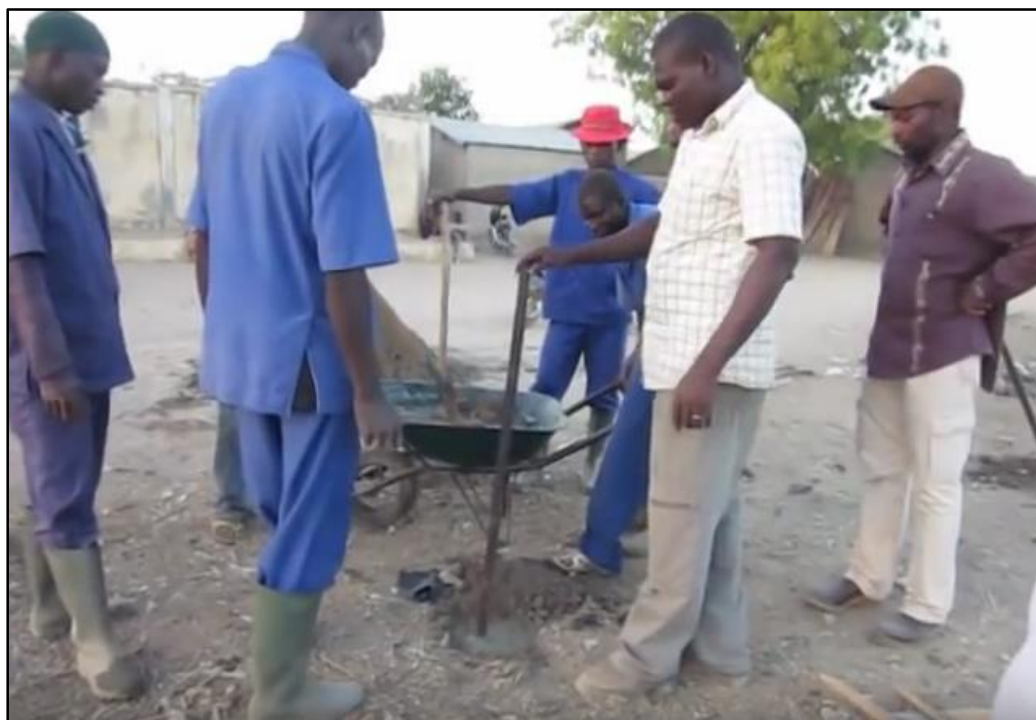
Installation clôture du complexe Arboretum-Pépinière avec les étudiants du CRA
