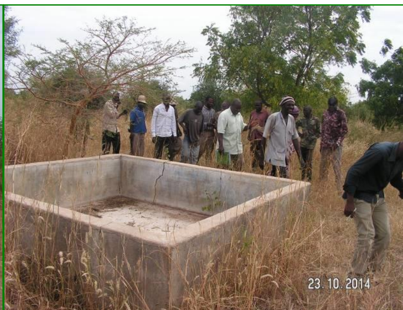
Bassin d'eau à réhabiliter sur le site de Massinkou/Kaélé
